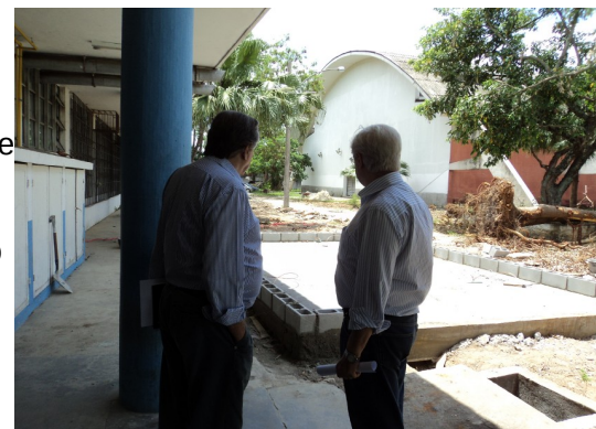
Peri Cozer e Roberto Nicolsky observam a obra da base para um novo transformador que ampliará a capacidade elétrica.
