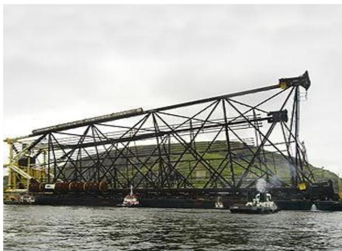
FIGURA 4.2 - Transporte de uma estrutura Jaqueta por Barcaça
