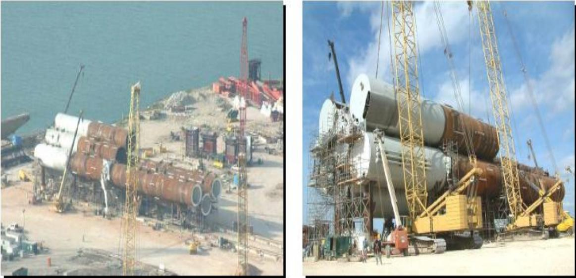
FIGURA 3.2 - Construção da plataforma CELL SPAR Assembly.
