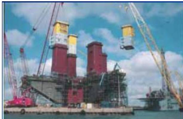
FIGURA 3.1 - Construção das Colunas da TLP
