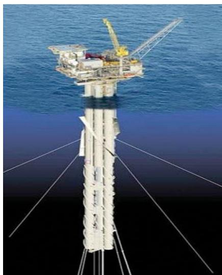
FIGURA 2.11 - Plataforma Cell SPAR
