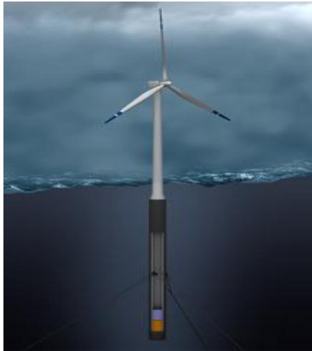
FIGURA 5.1 – SPAR como fonte de Energia Eólica
